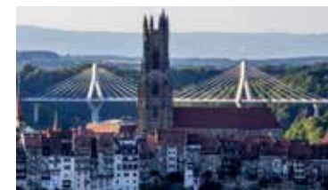
Pont de la Poya Poyabrücke Poya Bridge (2014)
