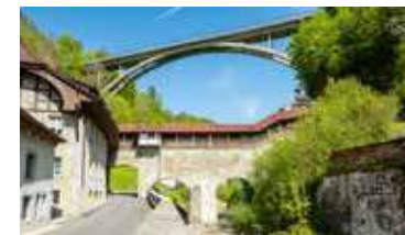
Pont du Gottéron Galternbrücke Gottéron Bridge (1950)
